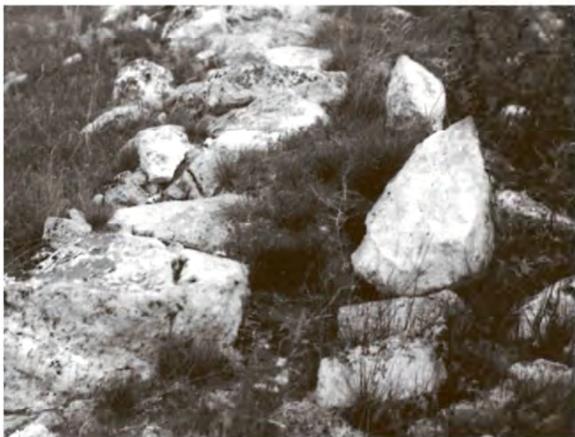
Фундамент мавзолея «Малый кэшэнэ». Фото 1972 года.
